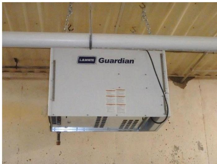
Figure 3. Fournaise au propane LB White de 50 000 à 100 000 BTU (30 kW).
