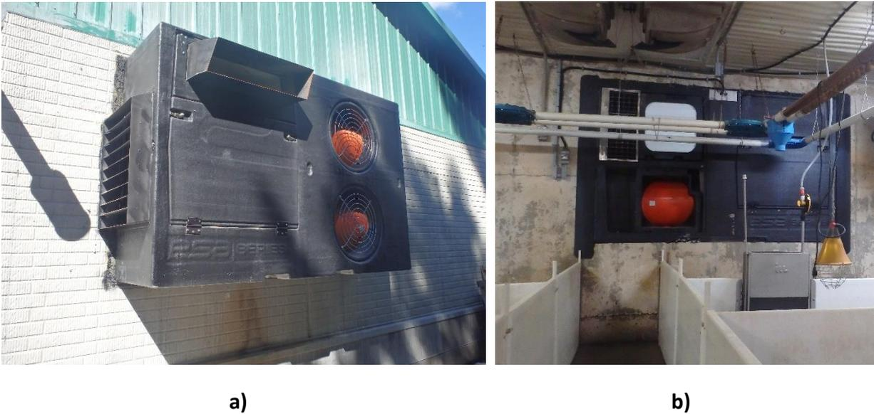
**Figure 6. Vue extérieure (a) et intérieure (b) de l'échangeur de chaleur air-air ESA-3000.**
