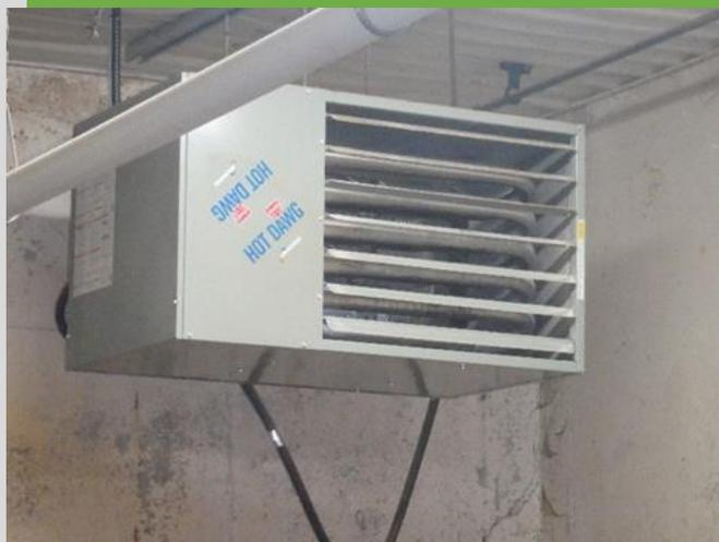
**Fournaise au propane avec rejet des gaz de combustion à l'extérieur du bâtiment (Modine HDS)**
