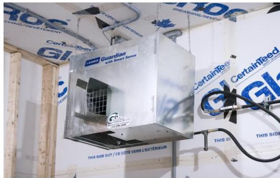
Figure 11 Aérothermes à intensité variable de 250 000 btu/h installés dans l'entreeit aux deux extrémités du bâtiment (un par extrémité)
