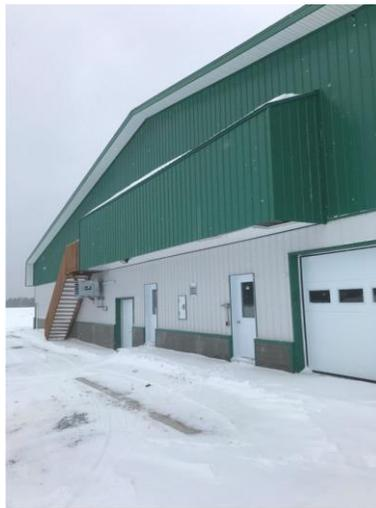
**Figure 8** *Vue de la prise d'air en pignon sur un côté du bâtiment*
