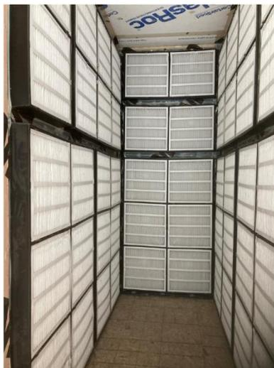
**Figure 9** *Bancs de filtres installés dans l'entretait aux deux extrémités du bâtiment*
