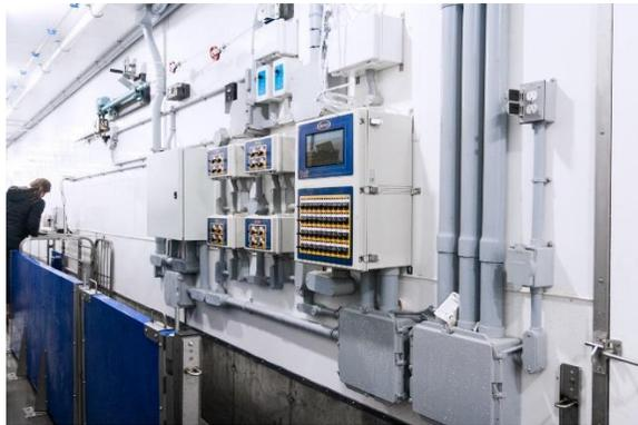
Figure 19 Système de contrôle d'ambiance
