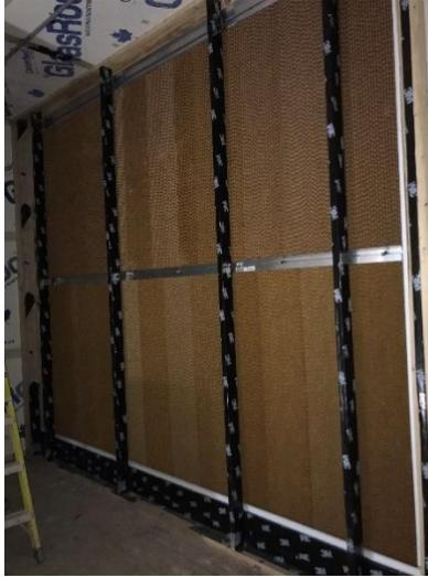
Figure 10 Rideaux d'évaporation (10' x 18') installés dans l'entreeit aux deux extrémités du bâtiment
