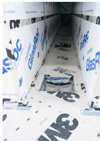
Figure 14 Plénum de distribution secondaire dans l'entretait avec ses entrées d'air plafonnier
