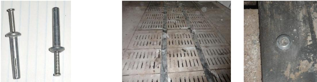
**Figure 16** Utilisation de rivets en acier inoxydable et de longues plaques de métal pour boucher les « trous » à fumier des lattes de gestation
