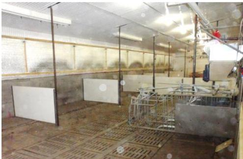
**Figure 17** Équipements, divisions de parcs en PVC et poteaux servant à les maintenir solidement
