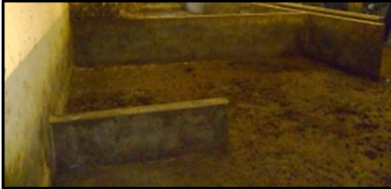
Figure 3 Plancher de béton plein dans les couchettes
