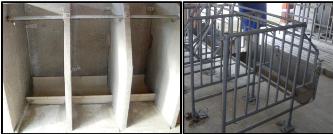
Figure 21 Bat-flancs pleins en béton et ajourés en métal
