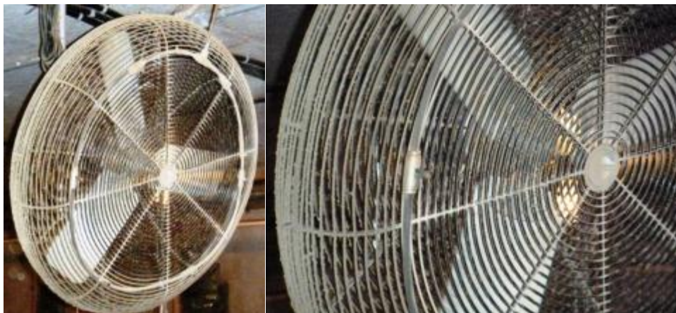
Figure 7 Système de brumisation du traitement B installé sur un ventilateur de recirculation
