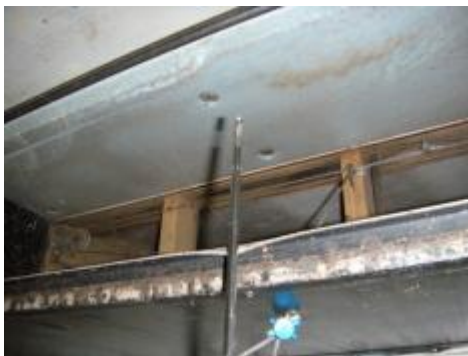
Figure 10 Mesure de la vitesse d'air à l'entrée d'air
