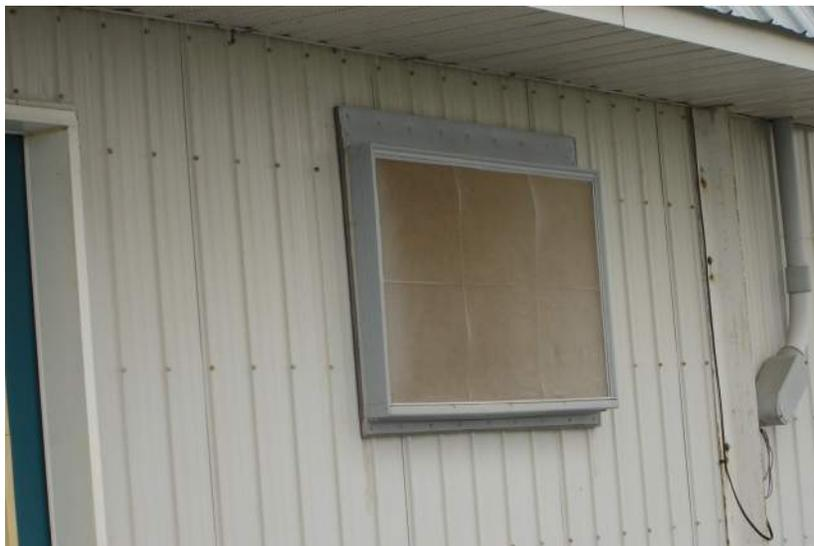
**Figure 13 : Fenêtre du bureau recouverte d'un filtre**
