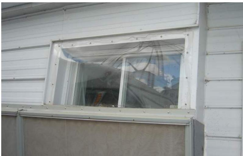
**Figure 14 : Fenêtre du bâtiment couverte d'un plexiglas (section pouponnière)**
