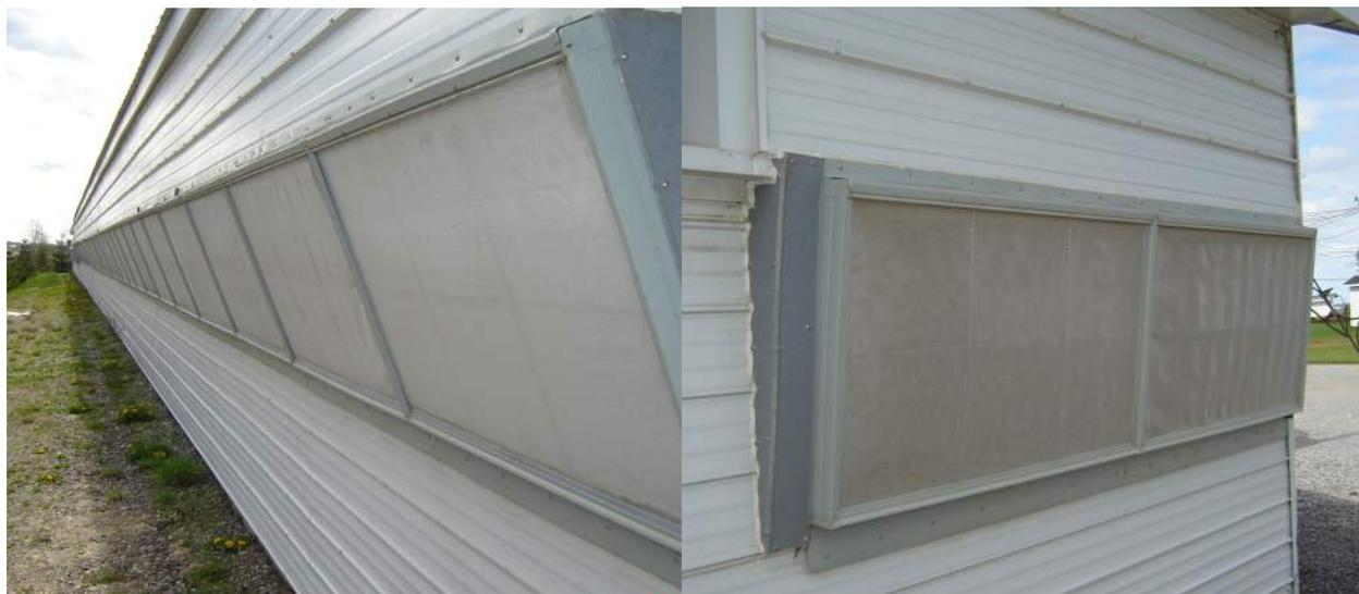
**Figure 9 : Filtres de la façade D2 (section engraissement)**
