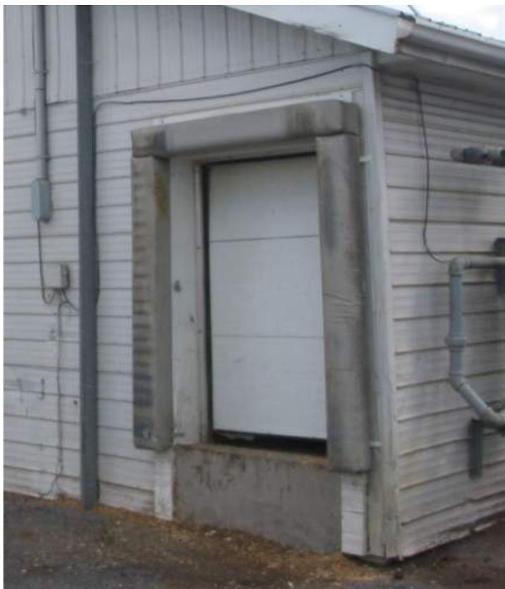
**Figure 16 : Coussins pour un arrimage étanche entre le camion et le bâtiment
