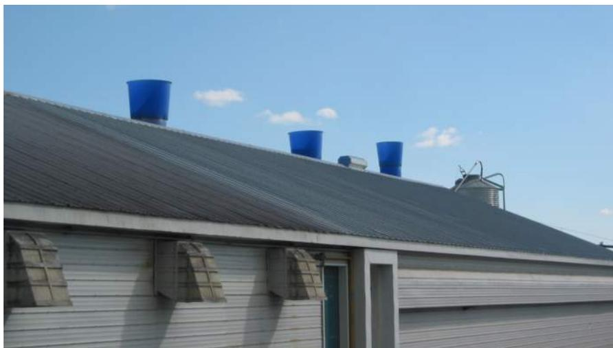
**Figure 12 : Ventilateurs de la façade D4 et ventilateurs cheminée (section engraissement)**
