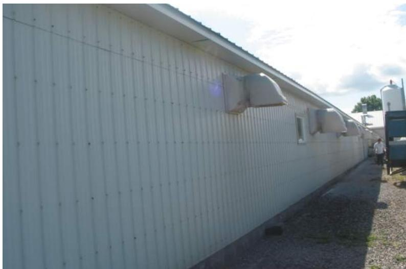
**Figure 4 : Ventilateurs de la façade A4 (section gestation)**
