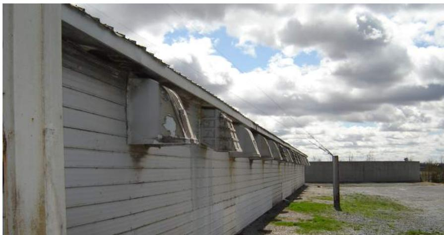
**Figure 8 : Ventilateurs de la façade C4 (section engraissement)**
