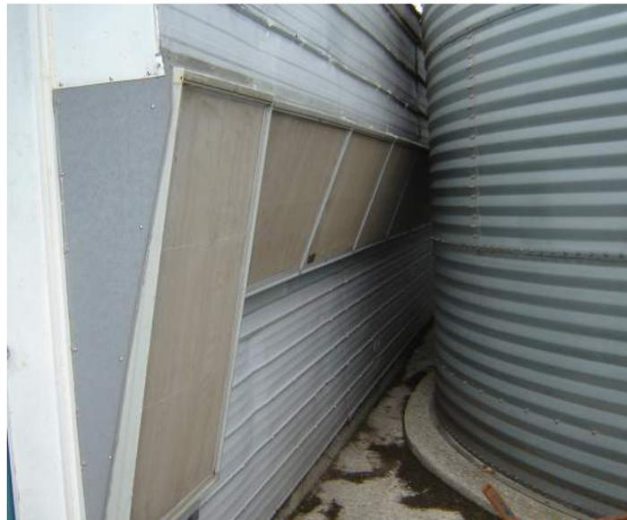
**Figure 7 : Filtres de la façade C2 (section engraissement)**
