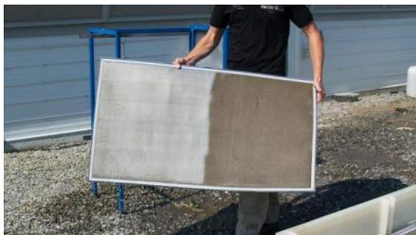
**Figure 3-1 Impact du lavage sur la propreté des filtres**
