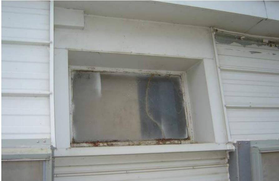
**Figure 15 : Fenêtre permettant l'infiltration d'air contaminé (section engraissement)**
