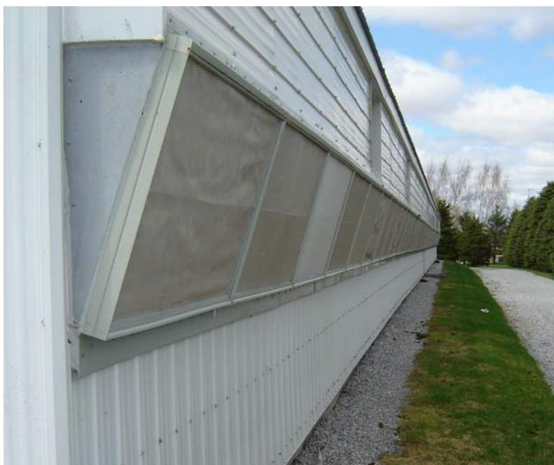
**Figure 3 : Filtres de la façade A2 (section gestation)**
