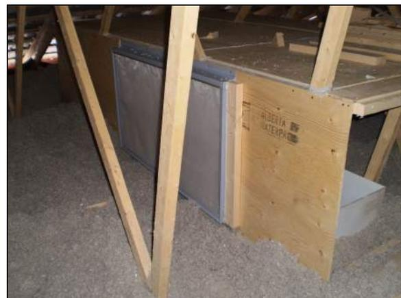
**Figure 23 : Installation de filtres sur deux entrées d'air modulaires dans l'entretoit**
