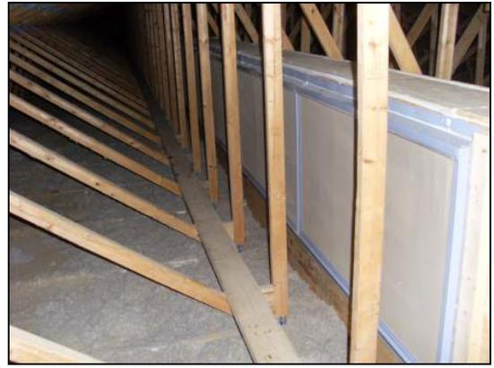
Figure 26 : Installation des filtres sur une entrée d'air linéaire continue dans l'entretoit
