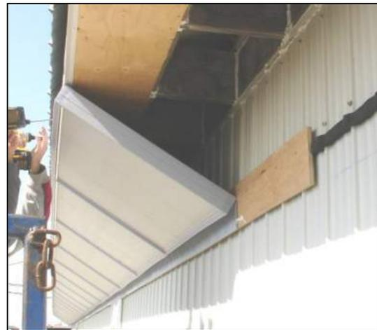
**Figure 7 : Fixation du boîtier de PVC**
