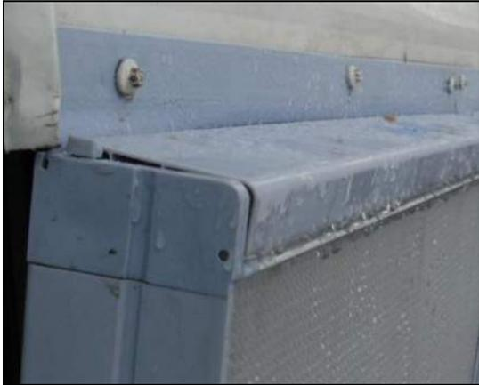
Figure 3 : Languette de plastique de type peinture dans le haut du cadre des filtres
