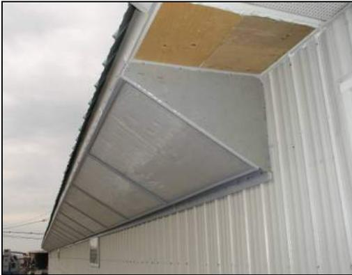
**Figure 18 : Fermeture du bout des filtres (installation sous la corniche)**
