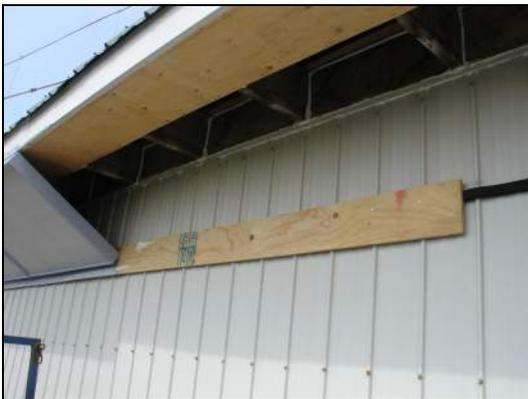
**Figure 6 : Contreplaqué bloquant la corniche et morceau de bois sur le recouvrement extérieur pour fixer le boîtier de PVC**
