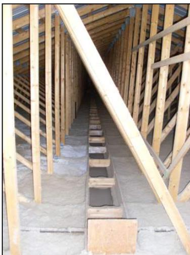
Figure 25 : Entrée d'air linéaire continue avant l'installation de filtres
