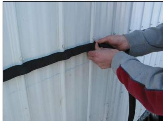
Figure 4 : Pose d'une bande de mousse sur le revêtement extérieur
