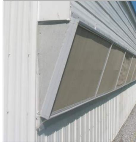
Figure 16 : Fermeture de l'extrémité de la rangée de filtres (installation sous l'abri-vent)
