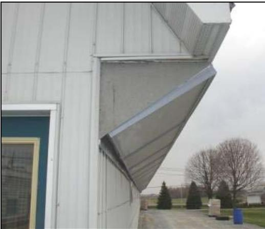
Figure 15 : Fermeture de l'extrémité de la rangée de filtres (installation sous la corniche)
