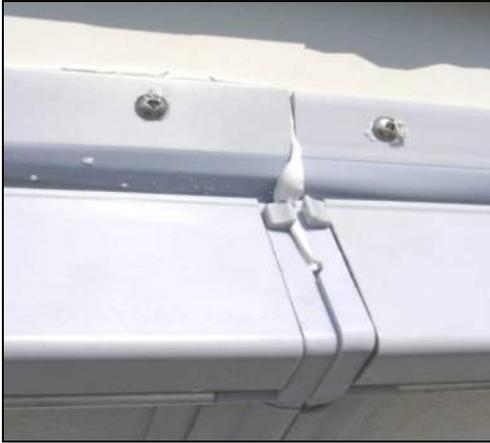
**Figure 9 : Joint d'étanchéité entre deux filtres**
