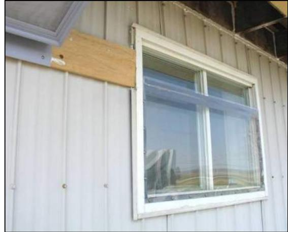
**Figure 11 : Fenêtre avec plexiglas avant l'installation du filtre**
