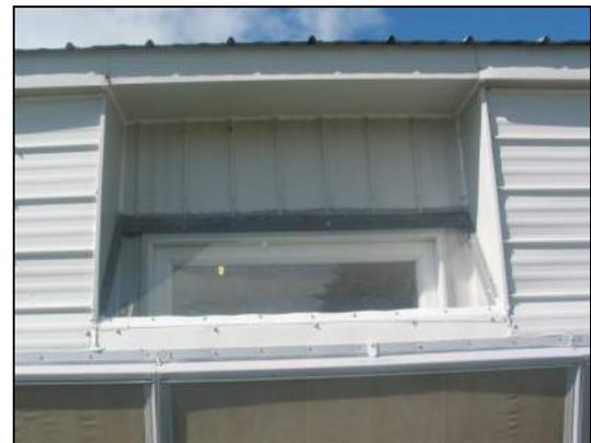
**Figure 13 : Fenêtre après l'installation de filtres (type 2)**
