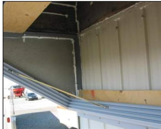
Figure 17 : Joint de calfeutre assurant l'étanchéité de l'embout
