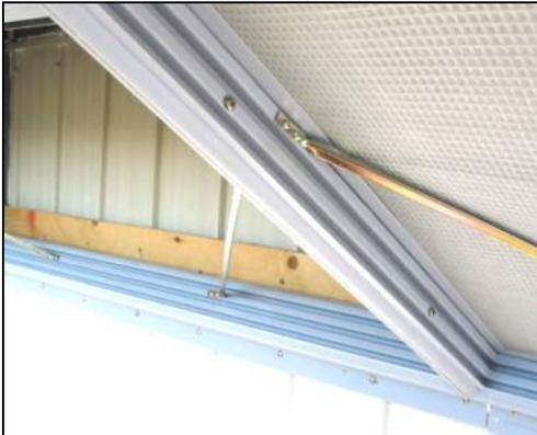
**Figure 10 : Fixation de deux filtres entre eux à l'aide de vis**
