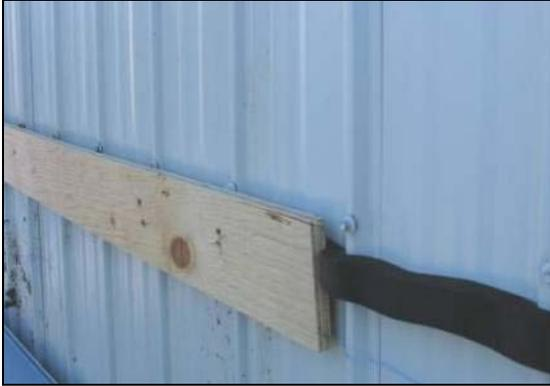
**Figure 5 : Fixation du morceau de bois sur la tôle**
