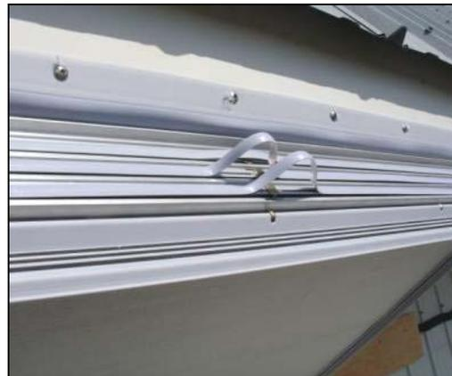
Figure 2 : Poignées permettant de sortir les cartouches de filtre du boîtier
