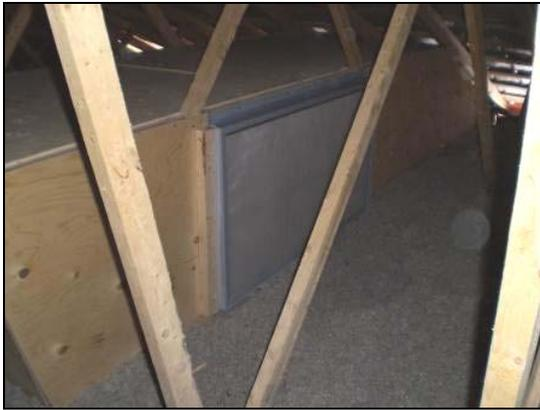
Figure 24 : Installation complétée sur plus d'une entrée d'air modulaire dans l'entretoit
