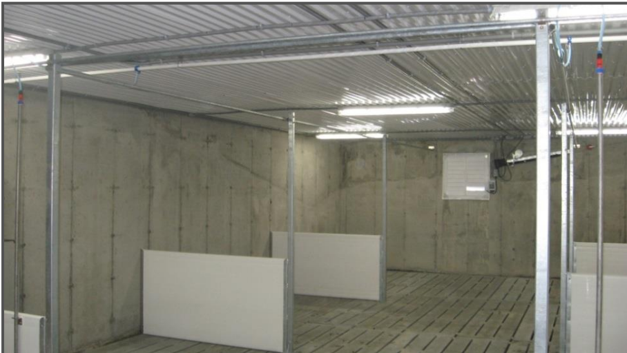
Figure 45 Zone de couchage entièrement lattée
