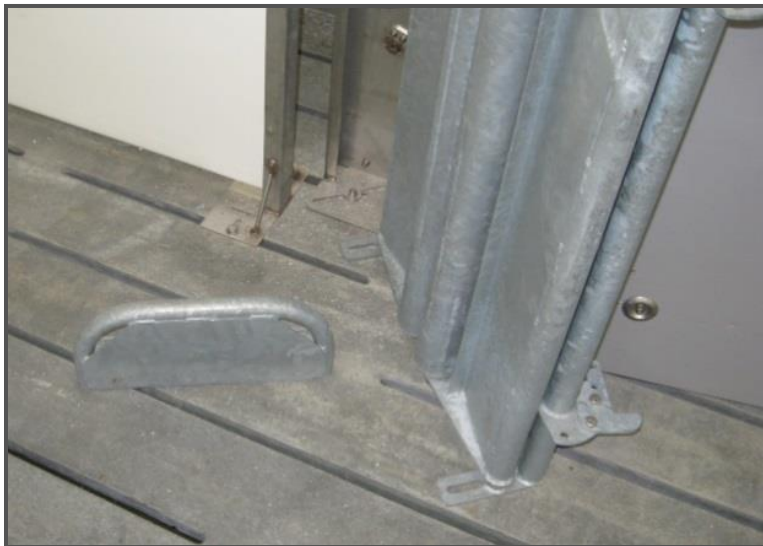
Figure 51 Barre anticouchage installée sur le plancher devant la porte de sortie d'un DAC
