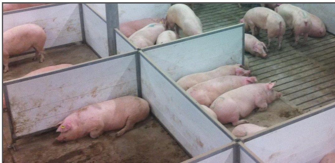
Figure 4 Plancher de béton plein dans les couchettes
