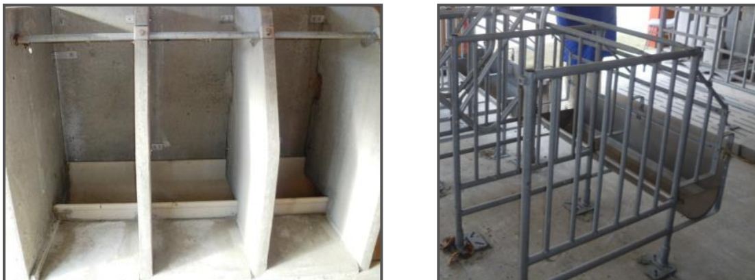
Figure 24 Bat-flancs pleins en béton et ajourés en métal
