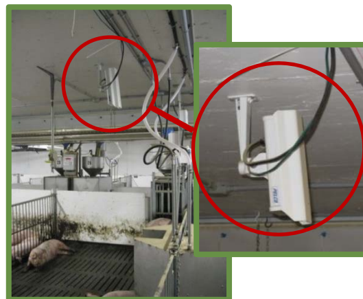
Caméra infrarouge FLIR A325cs dans son boîtier de protection installée à la Station
