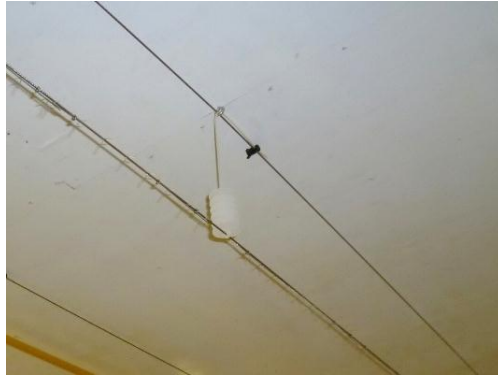
Figure 2 Lignes de décharge d'ions avec pointes et isolateur du système d'ionisation
