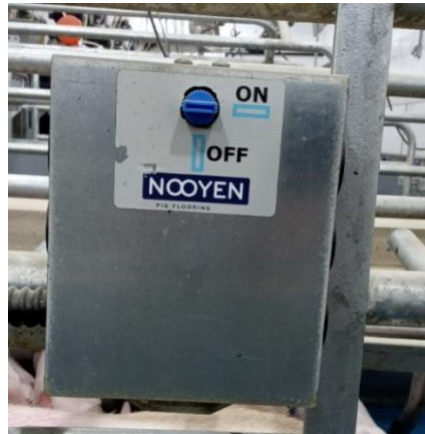
Figure 11. Contrôle individuel des cases ascenseurs.
