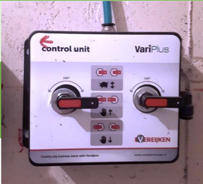
Contrôle des cases ascenseurs
